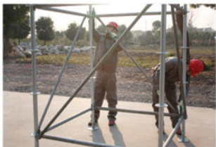
步骤七： 首层斜杆安装
