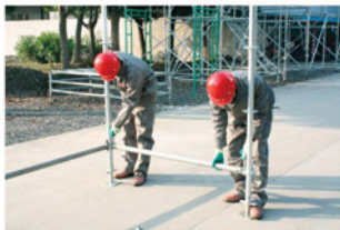
步骤四： 首层架体向四周扩展安装
